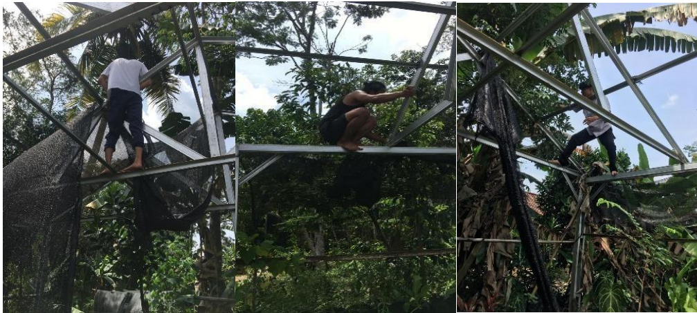
Gambar 2. Perbaikan paranet di Greenhouse
