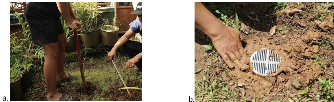
Gambar 2. a. Pengeboran tanah; b. Instalasi biopori yang telah terpasang
