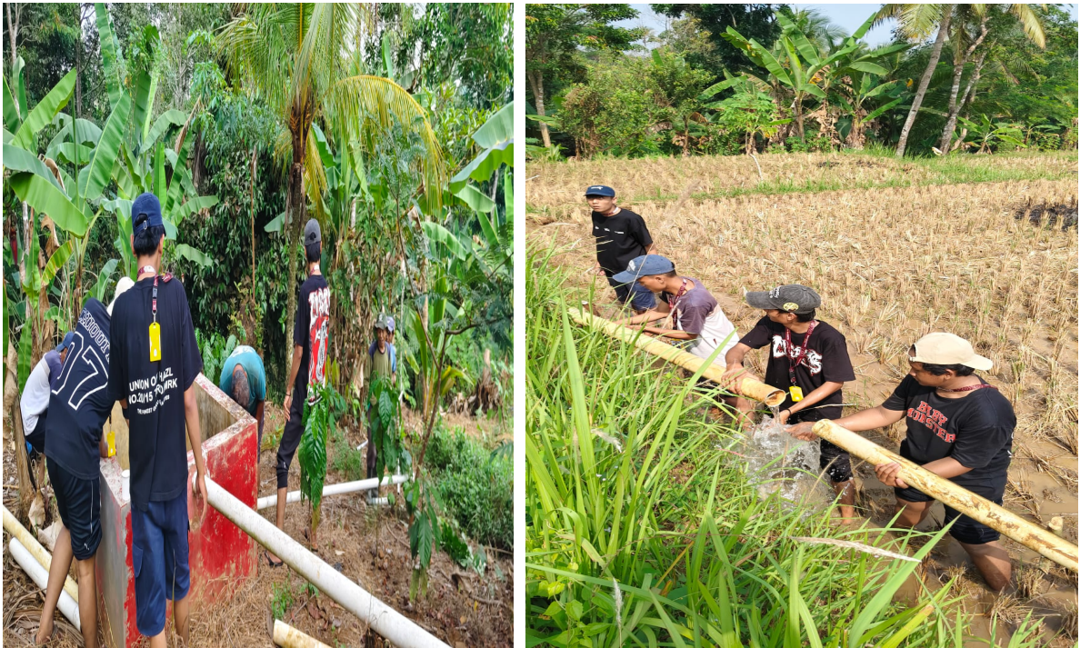
Gambar 2. Proses rehabilitasi jaringan irigasi di Desa Cicinggang.
