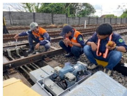
Gambar 4. Perawatan dan Pemeliharaan Motor Wesel Tipe NSE
