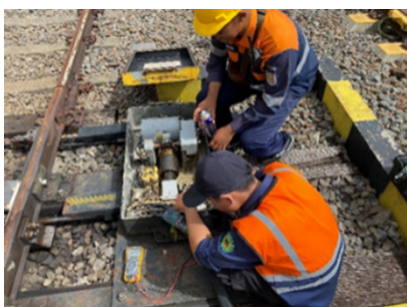
Gambar 2. Perawatan dan Pemeliharaan Motor Wesel Tipe T84M
