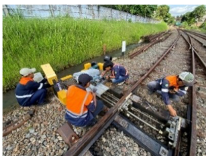
Gambar 3. Perawatan dan Pemeliharaan Motor Wesel Tipe BSG9
